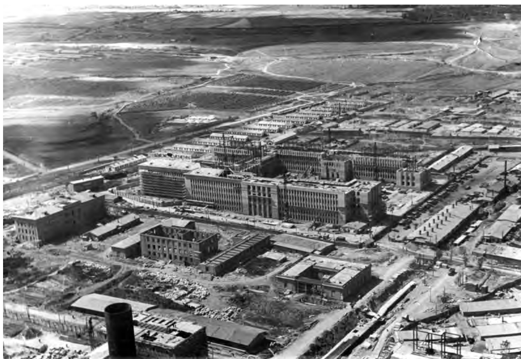
Строительство корпуса биолого-почвенного факультета на Ленинских горах. 1952 г.
