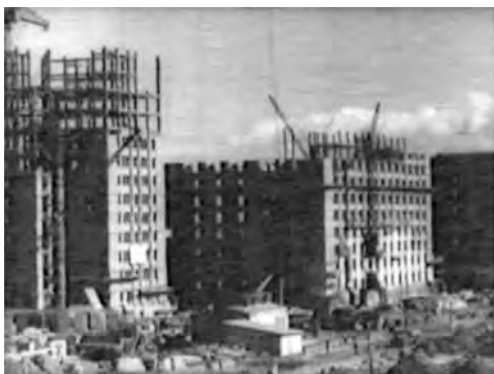
Начало строительства главного здания (кадр из фильма)
