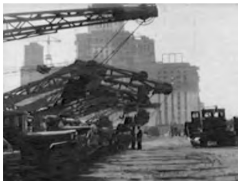
Спецтехника на строительной площадке перед главным зданием (кадр из фильма)
